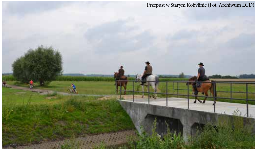
Przepust w Starym Kobylinie (Fot. Archiwum LGD)
