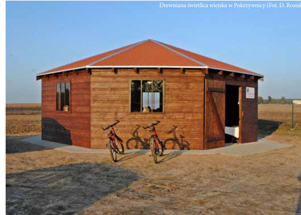
Drewniana świetlica wiejska w Pokrzywnicy (Fot. D. Rosiak)
